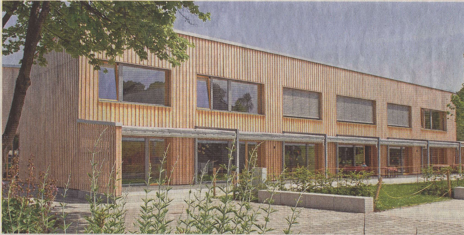
Die Kemptener Architekten Jörg Heiler und Peter Geiger haben den Kinderhort „Einstein“ in Sankt Mang geplant. Das energetisch als Passivhaus geltende Gebäude für 75 Kinder kann am Samstag um 12 Uhr besichtigt werden.
